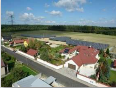
FVE v Ševětíně 302 kW
